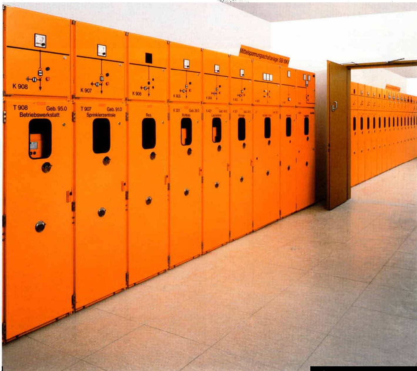
Metallgekapselfte, fabrikfertige Schaltanlage in einem großen Produktionsbetrieb, ausgerüstet mit dem Lichtbogenwächtersystem LWS.
